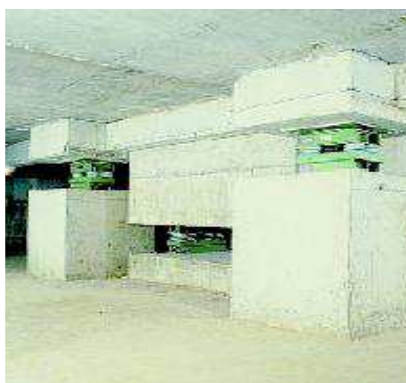
Vue du dessous de la salle
